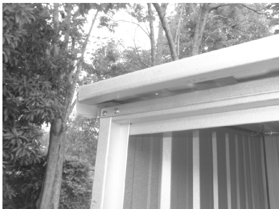
CORNER DOOR JAMB ASSEMBLY
